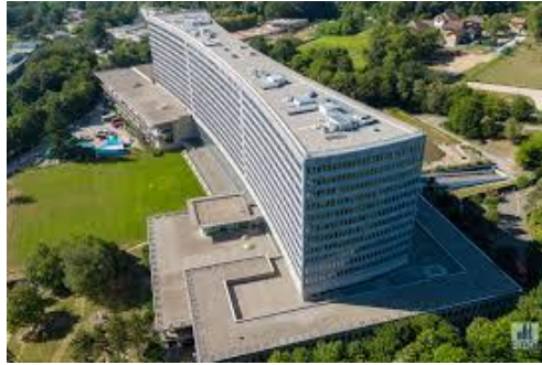
Figuur 15: Het gebouw van de IAO in Genève
